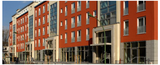
Unser Energieberatungszentrum und Büro im Passivhaus finden Sie im Frankfurter Stadtteil Bockenheim im SophienHof.
